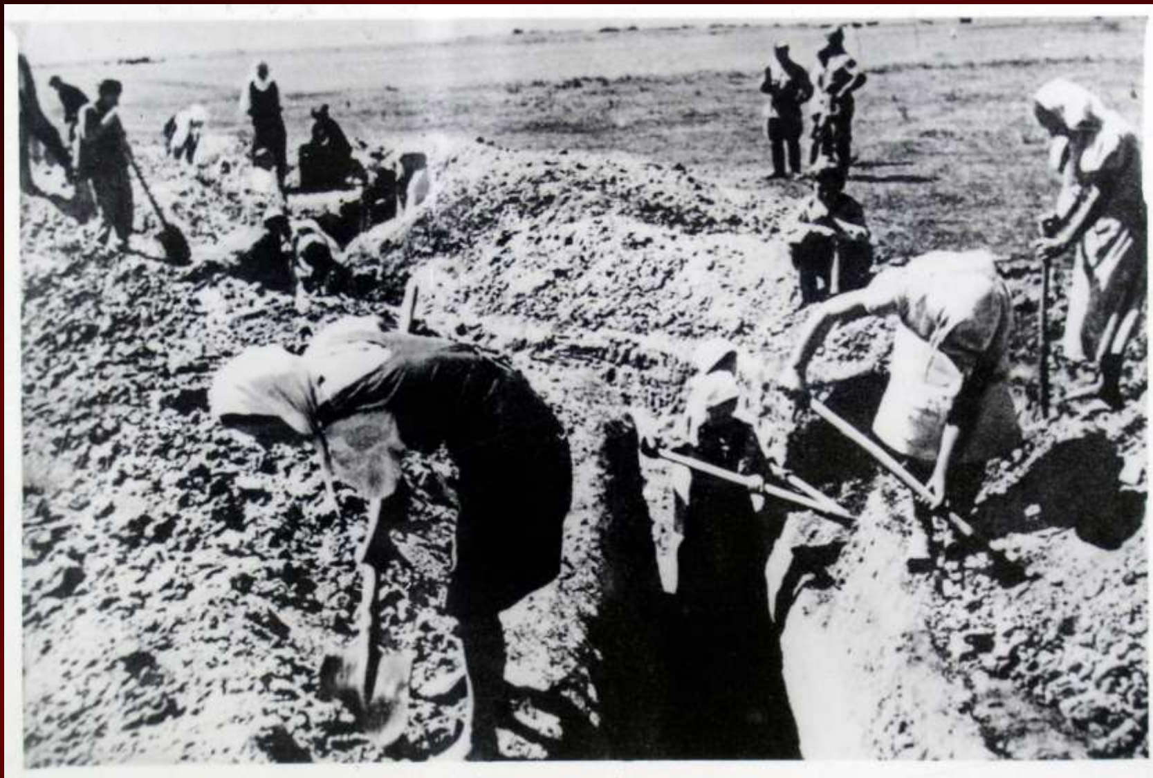
Жители донских станиц строят оборонительные сооружения. 1942 г.
