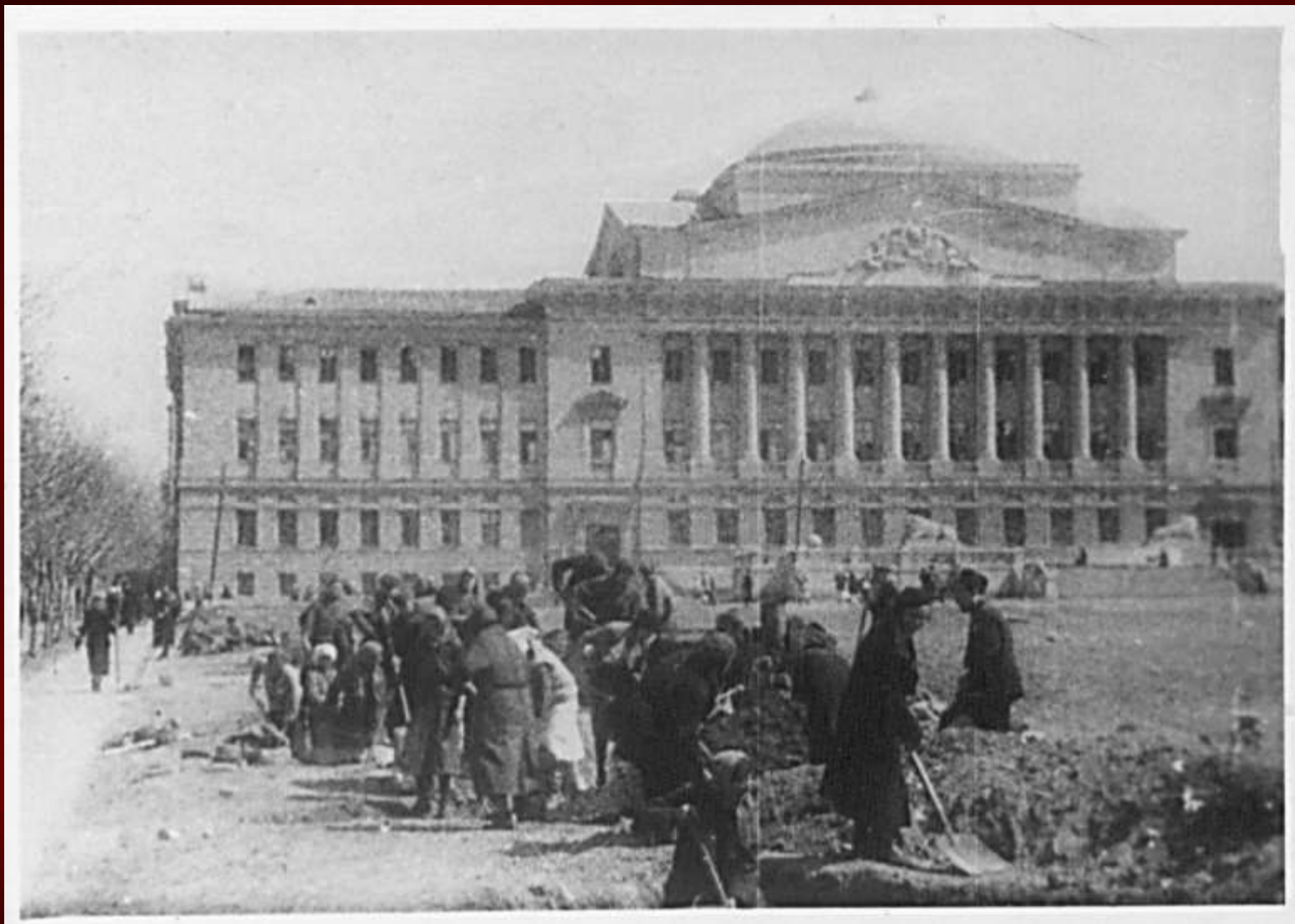
Строительство оборонительных сооружений в г.Ростове-на-Дону. 1943 г.
